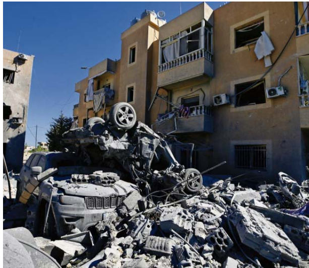
EDIFICIOS DAÑADOS TRAS LOS ATAQUES ISRAELÍES EN EL SUR DEL LÍBANO.
